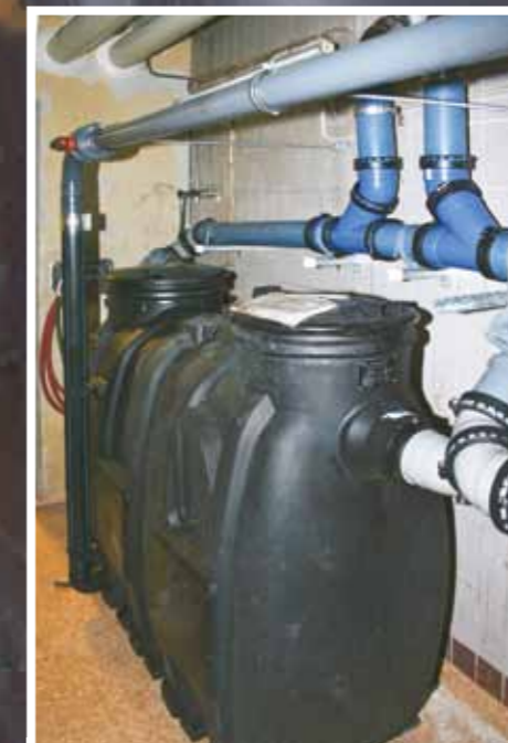
Standardile EN1825-1 vastavalt peavad rasvafiltrid olema paigaldatud juhul, kui rasva kipub kanalisatsiooni uhtuma juba olulisel määral.
