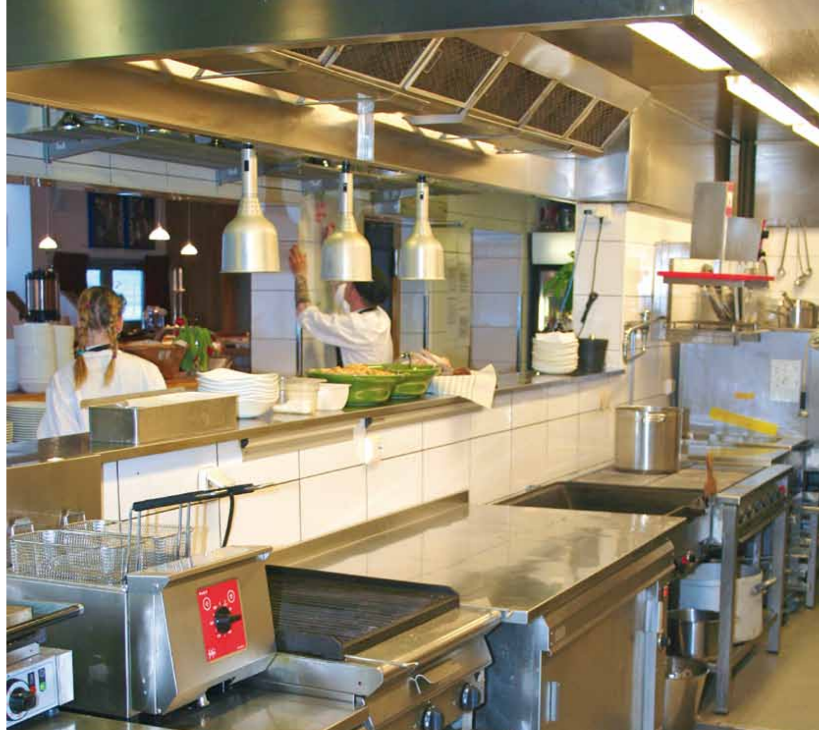
Вытяжка до установки озонатора ICT
